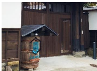
富谷宿観光交流ステーション (富谷市)
