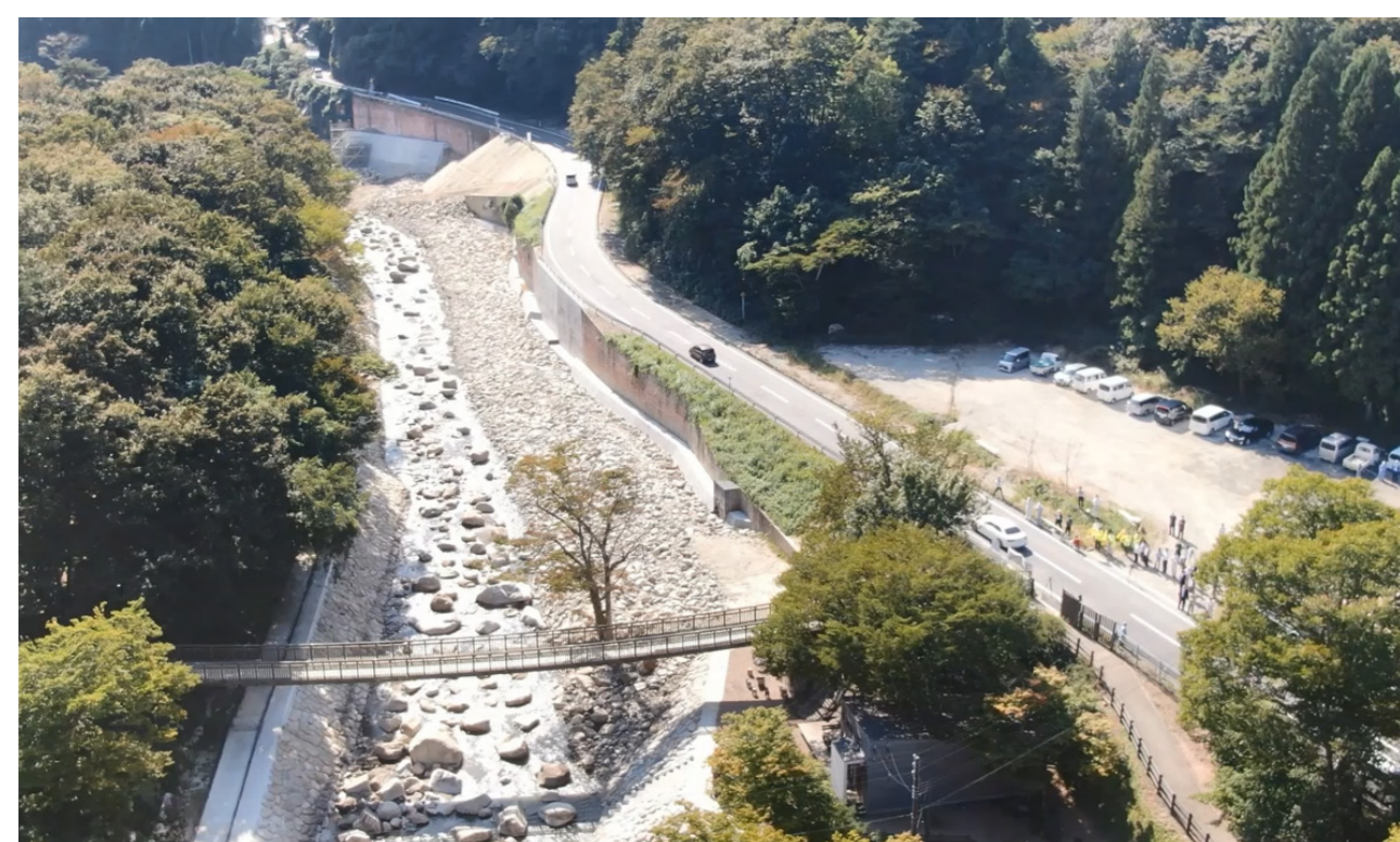
(主)丸森霊山線 復旧通行止め解除 令和4年(2023)
