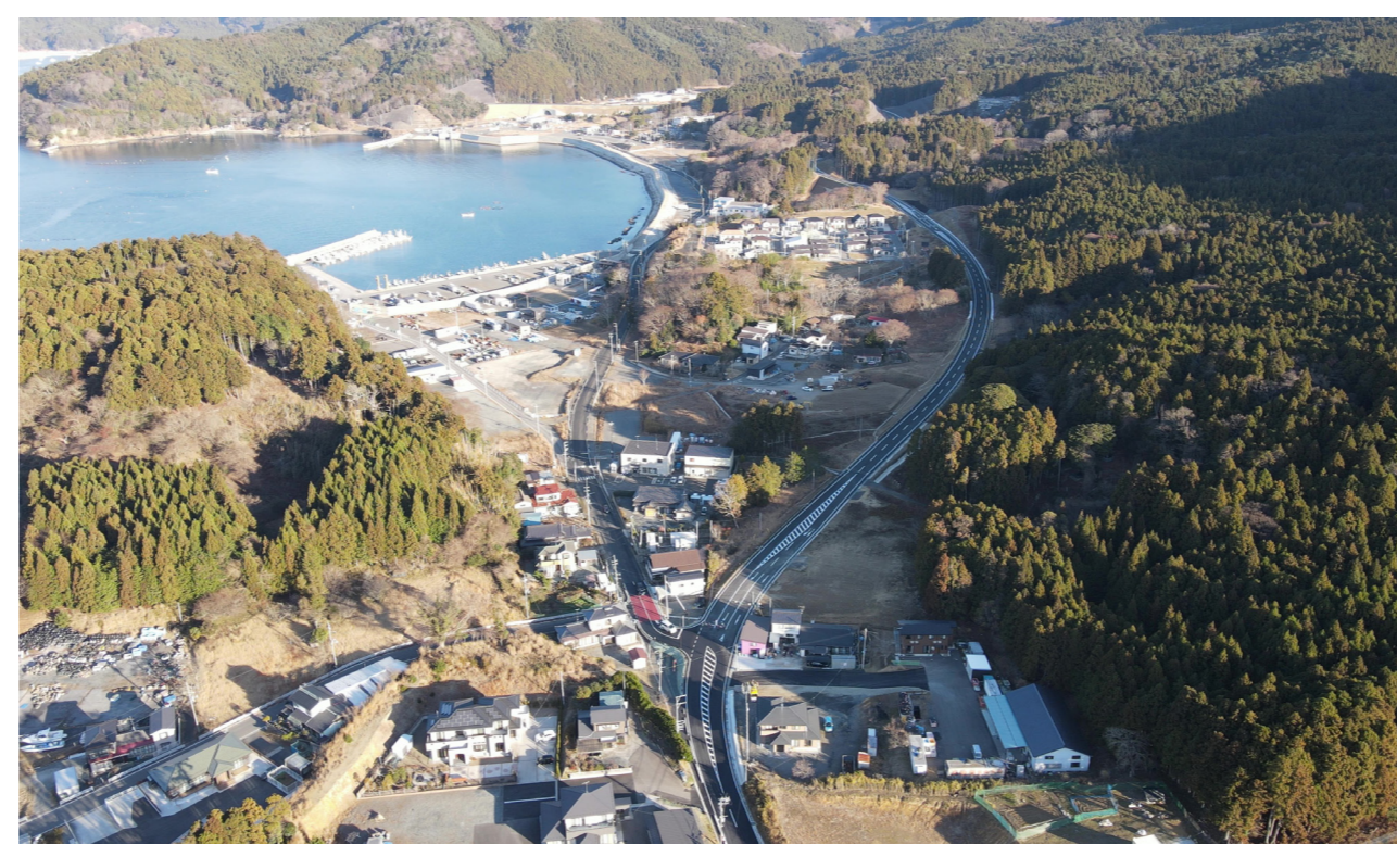
(主)石巻鮎川線 給分浜復興道路開通 令和4年(2023)
