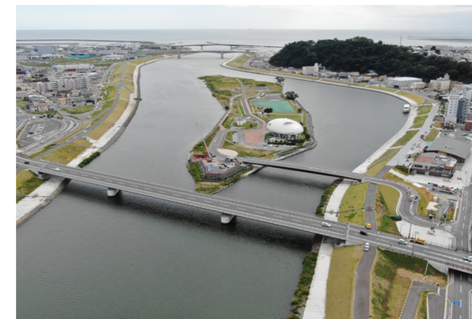
国道398号 内海橋開通 令和2年(2021)
