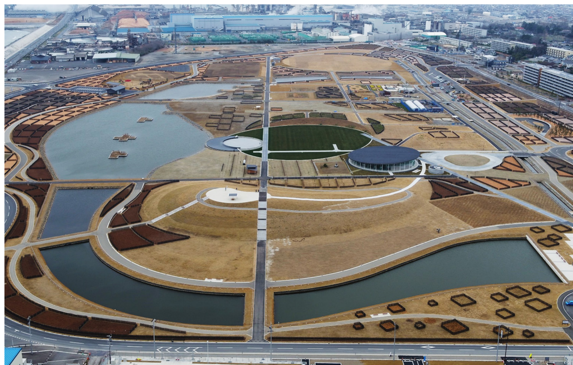
石巻南浜津波復興祈念公園開園 令和3年(2022)
