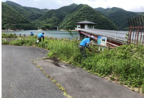
図2-4 令和4年6月21日 セツ宿ダム取水塔周辺
