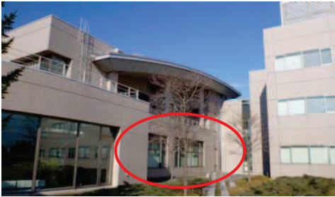
場長室, 応接室外観。サッシの上にガラリーがあります。
