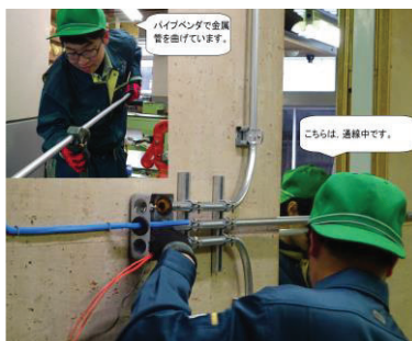
金属管工事实習
