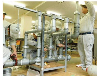
配管施工実習 (模擬家屋設備実習)
