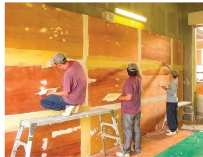
建築物塗装実習 (下地処理)
