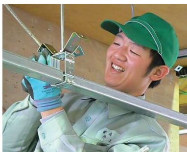
レースウェイ取付実習
