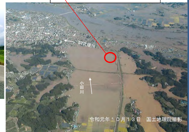
被災状況 <令和元年東日本台風>
