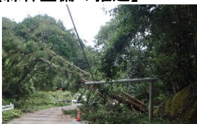
倒木により電線断線
