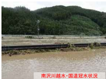
南沢川越水・国道冠水状況
