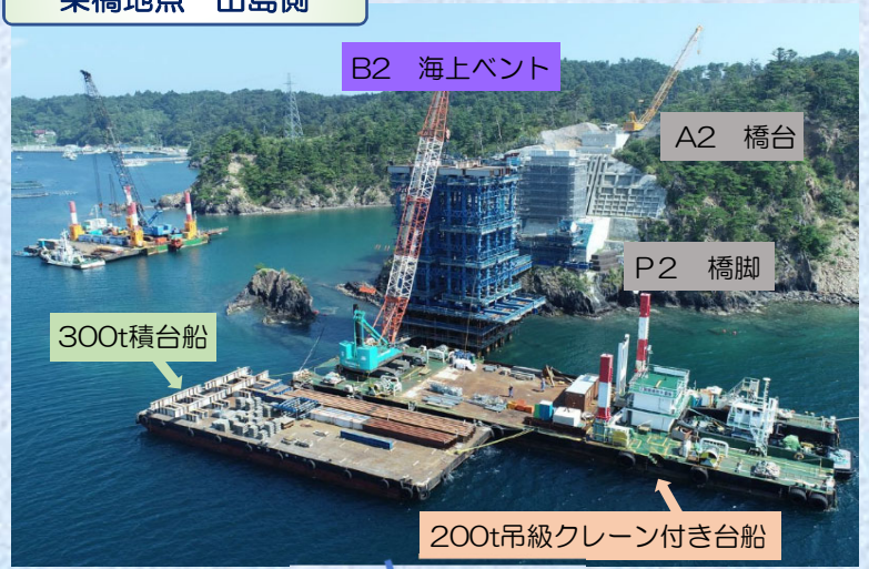
架橋地点 出島側
