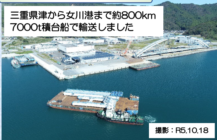
側径間ブロックの海上輸送状況
