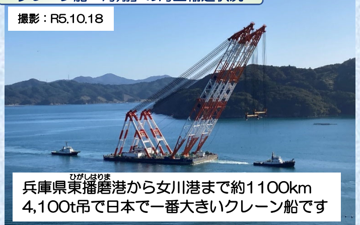
クレーン船「海翔」の海上輸送状況
