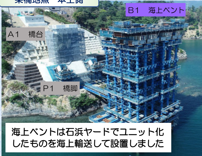
架橋地点 本土側
