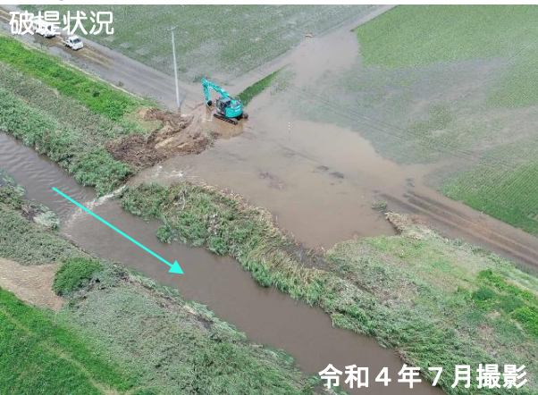
矢目排水機場付近（0.3k地点）の破堤箇所
