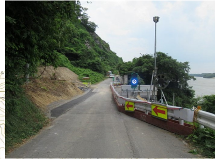
復旧後の状況
