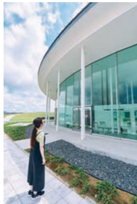
一番高い北側の屋根は、この地を襲った津波と同じ高さ(6.9メートル)。見上げると、その高さを実感する。
