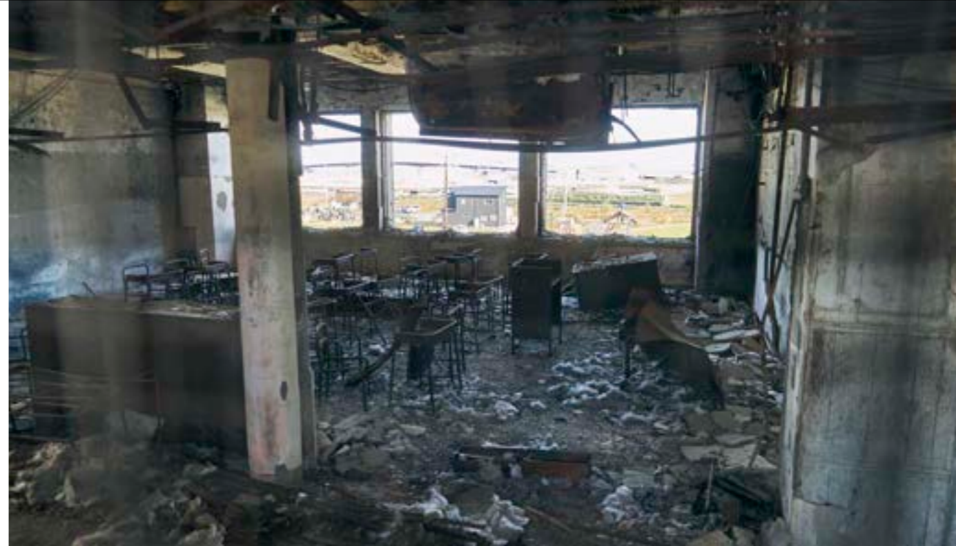
1階に津波と火災、2階と3階に火災が襲った本校舎。机と椅子が当時のまま並ぶが、天井まで焼け落ち鉄のみが残る。当時の被害の大きさを肌で感じる。
