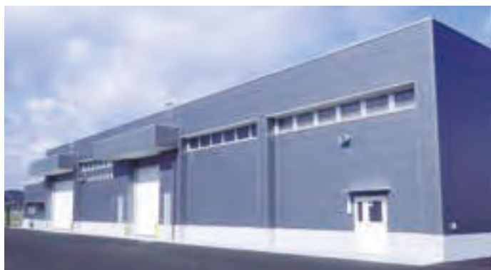
防災拠点施設(防災倉庫)外観
