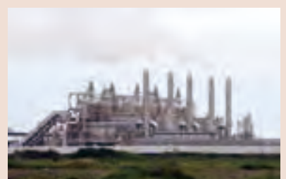
▲【2012年3月24日】1日525tの焼却が行える災害廃棄物処理場
