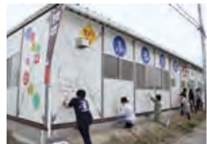
公共ゾーン地区(当時)に整備された仮設店舗
