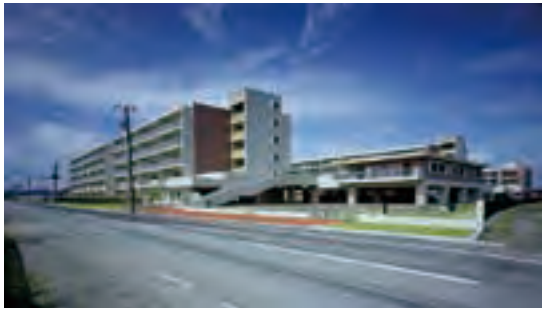
災害公営集合住宅(西木倉住宅)
