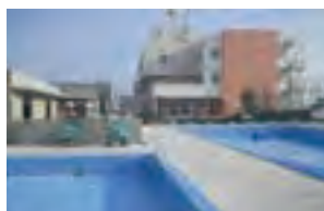
復旧した荒浜小学校のプール
