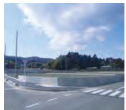
造成された防災集団移転先地(吉田南河原団地)
