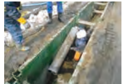
震災で壊れた上下水道管復旧工事の様子
