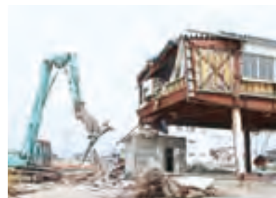
解体される旧宮城県漁業協同組合巨理支所
