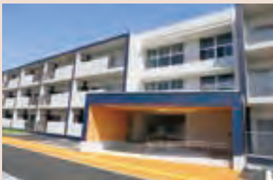
▲【2015年7月20日】 大谷地住宅完成により災害公営住宅と集団移転先団地整備が完了
