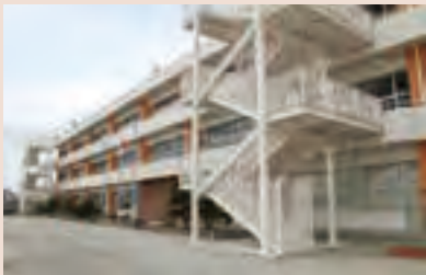
▲【2014年3月18日】校舎南面に設置された荒浜小学校の避難用外階段
