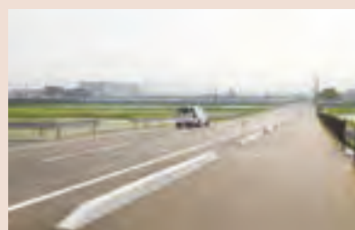
▲【2020年6月1日】震災時、沿岸部から内陸部へ迅速に避難するための避難道路「荒浜江下線」が完成・開通
