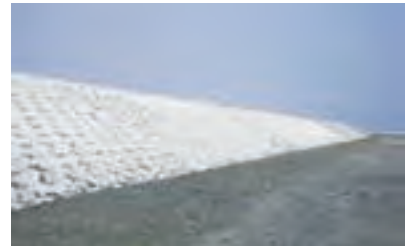
整備された高さ7.2mの防潮堤
