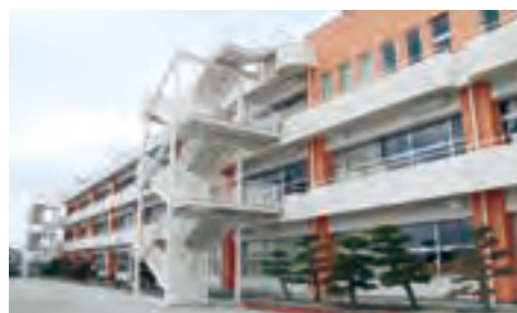
復旧した荒浜小学校
