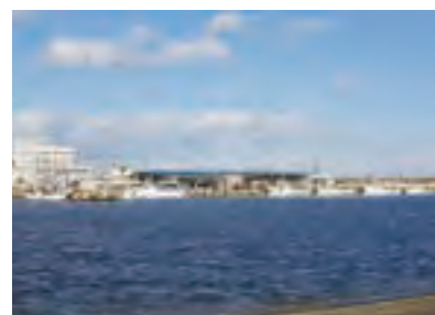
復旧された漁港・港湾施設
