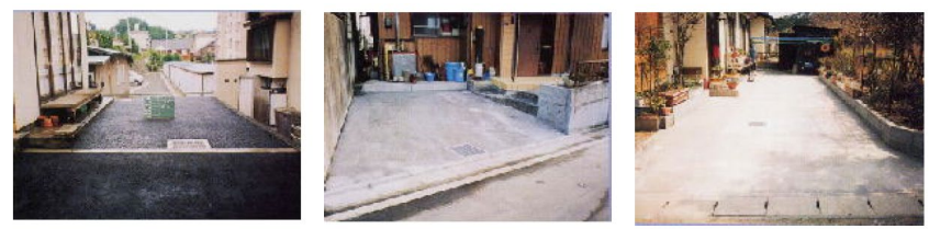
竣工 竣工 竣工
