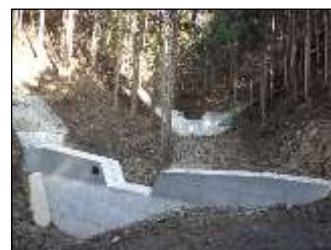
治山施設の整備
