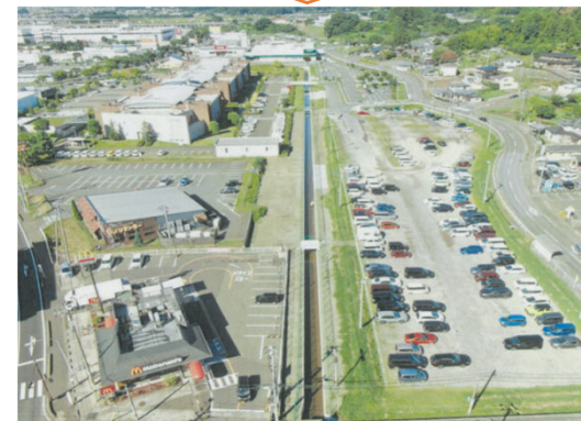
令和4年度雨水幹線改修（完成後）
