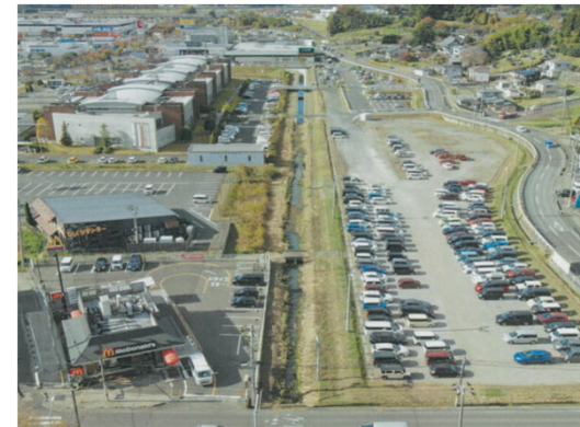
令和4年度雨水幹線改修（着工前）
