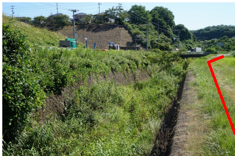
砂押川（宮城郡利府町沢乙地内）
