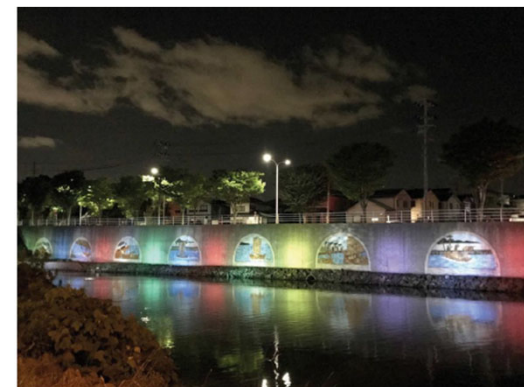
砂押貞山運河 親水空間の創出 景観形成の工夫
