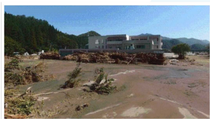
平成28年台風第10号による被害状況
