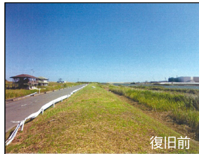
○七北田川（仙台市宮城野区蒲生地内）
