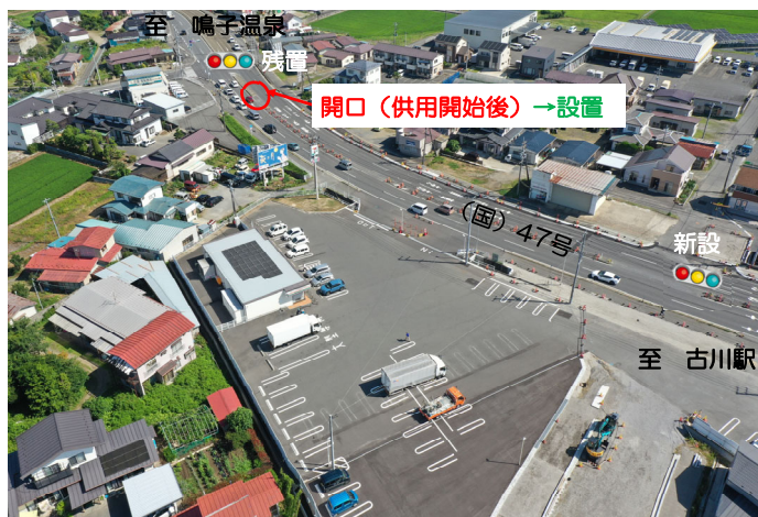
【現況写真】国道47号交差点
