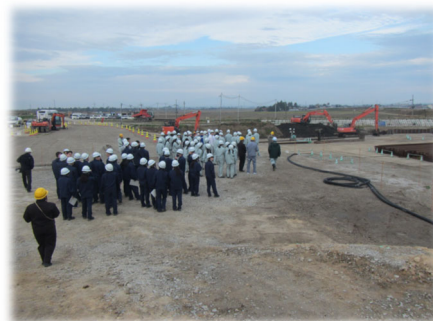
工事現場見学
