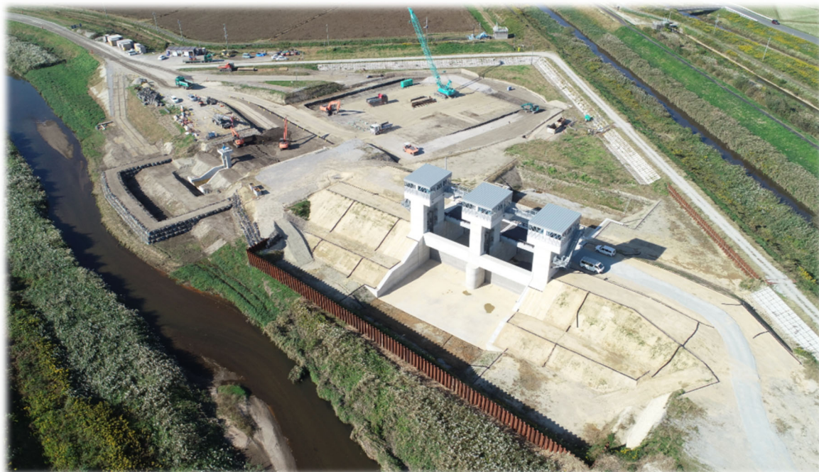
R6.10月末時点 現場状況
