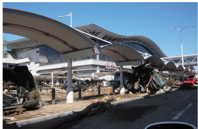
仙台空港の被害
