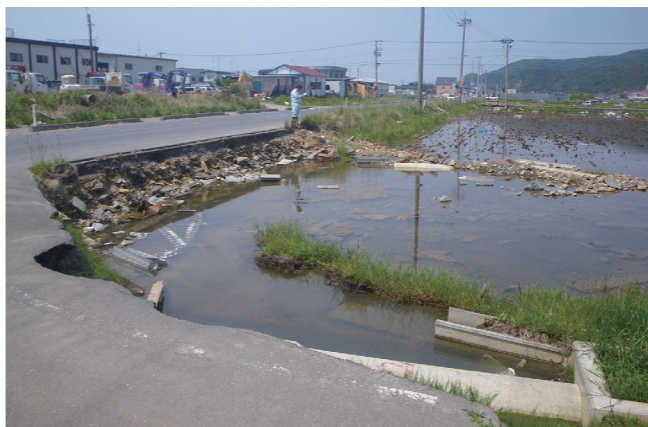
浸水した水田（石巻市）
