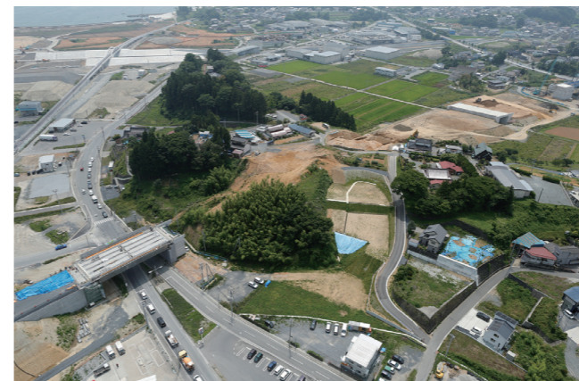
城跡を横断する三陸沿岸道路(気仙沼市小屋館城跡)
