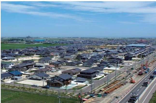
防災集団移転促進事業・岩沼市玉浦西地区（平成27年7月）
