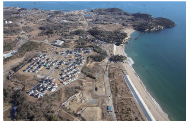
防災集団移転促進事業・七ヶ浜町笹山地区（平成28年2月）
