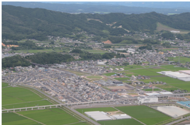
津波復興拠点整備事業・山元町新山下駅周辺地区（平成30年7月）
