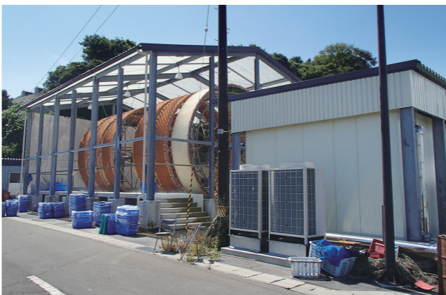
復旧した塩釜市浦戸桂島ノリ陸上採苗施設
