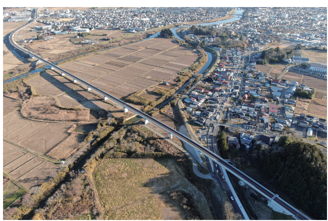
みやぎ県北高速幹線道路
