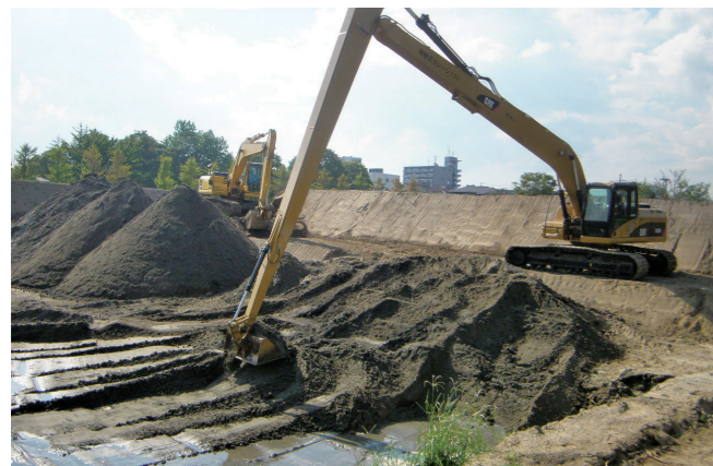
仮設沈殿池での汚泥撤去(仙塩流域下水道)
