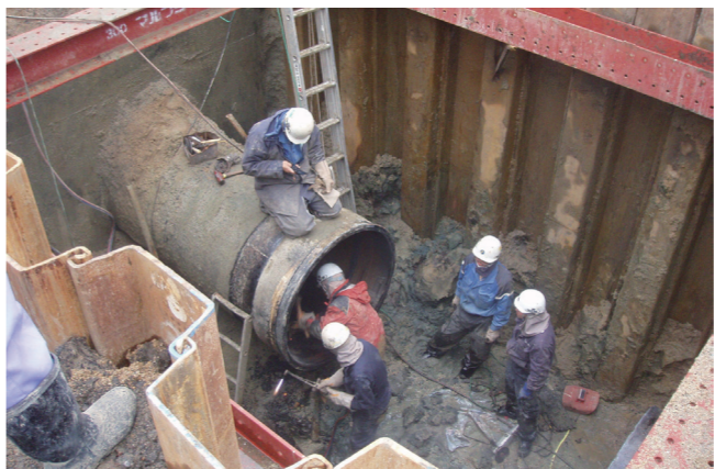
仙南・仙塩広域水道送水管復旧工事(白石市)
