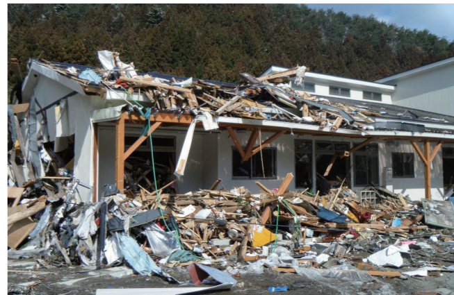
雄勝保育所の被害(石巻市)
