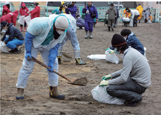
石巻市鹿妻保育所で泥出し作業をするボランティア
