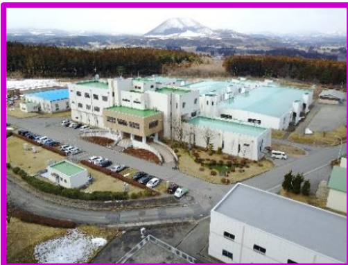
麓山浄水場（仙台北部工水）
