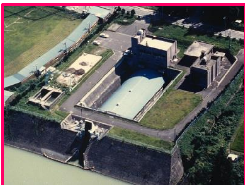
熊野堂取水場（仙台圏工水）
