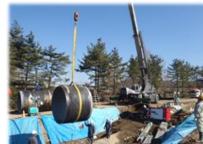
管路等の 維持管理・更新工事
