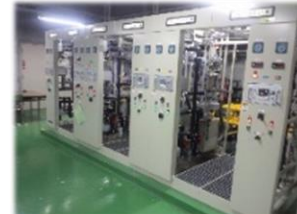
設備機器の 修繕・更新工事
