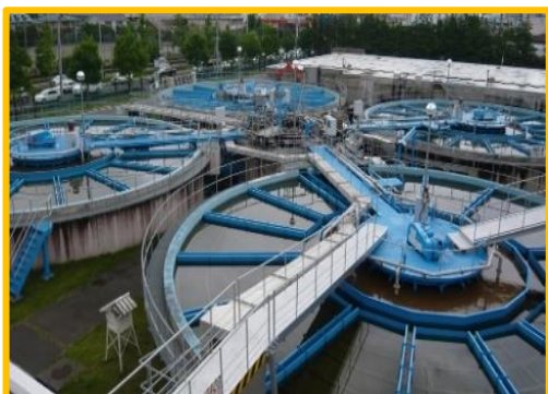
大樋浄水場（仙塩工水）
