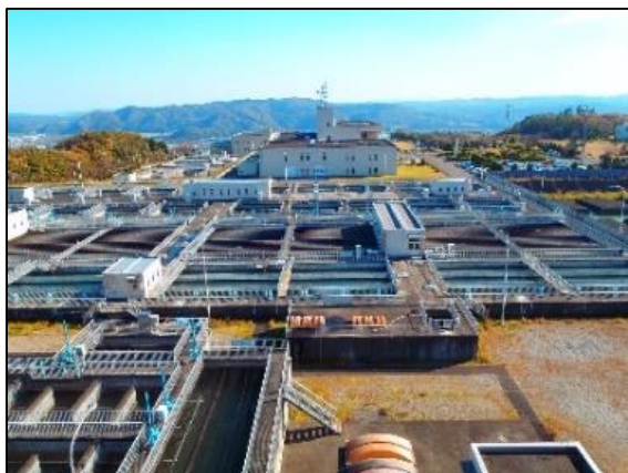
南部山浄水場
