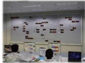
流量・水圧等の監視 (24時間・365日)
