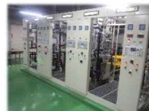
設備機器の 修繕・更新工事
