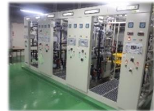
設備機器の 修繕・更新工事
