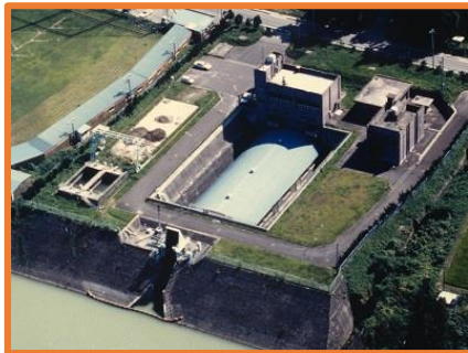
熊野堂取水場（仙台圏工水）
