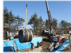
管路等の 維持管理・更新工事
