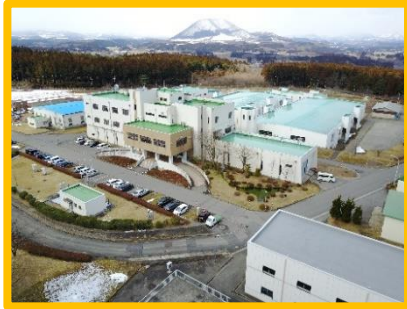
麓山浄水場（仙台北部工水）
