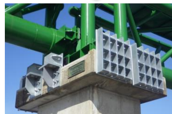
落ちないように装置を取り付け
