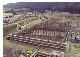
建物等の改築
