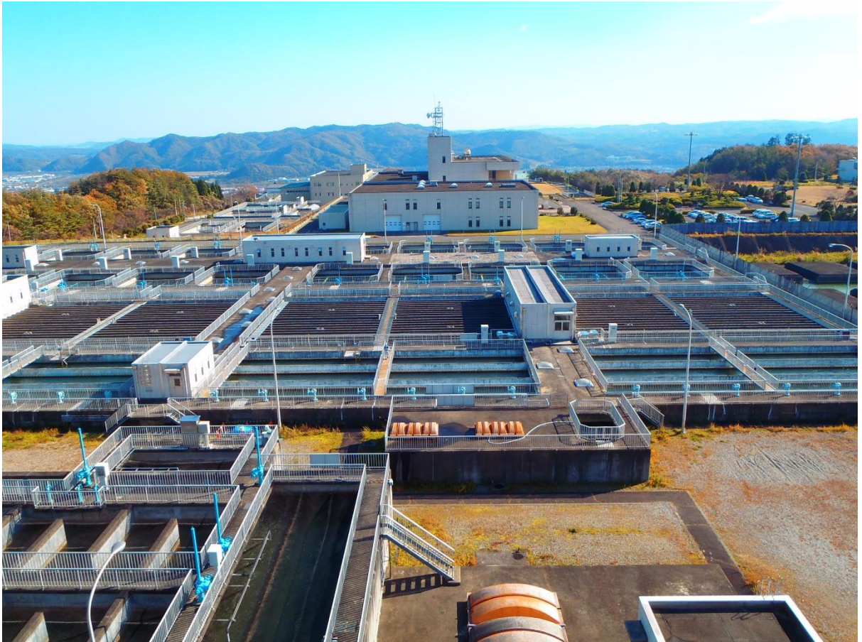
【南部山浄水場】(白石市内)
