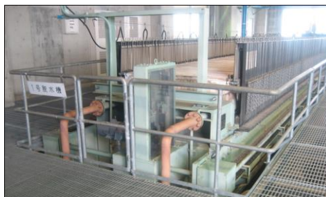
平成元年設置の老朽化した脱水機 (現在更新中)
