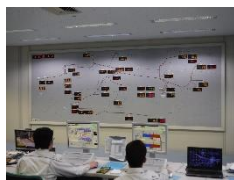
流量・水圧等の監視 (24時間・365日)
