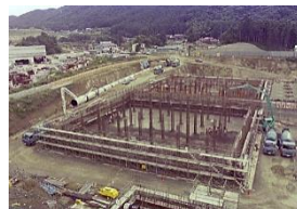
建物等の改築
