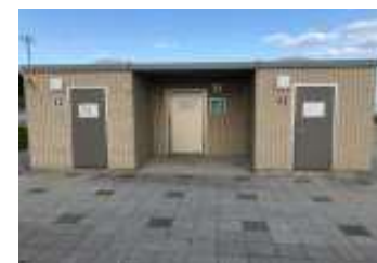
バリアフリー化の対象となる現地のトイレ棟 58
