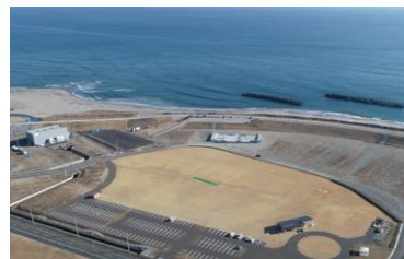
舗装整備の対象となる鳥の海公園
