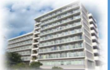
下愛子県職員寮 (仙台市青葉区)
