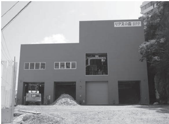
▲木質バイオマス熱電供給施設
