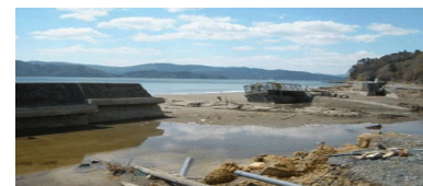
白浜海岸 (石巻市) 被災状況
