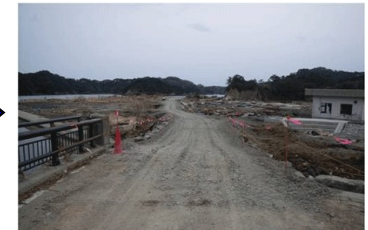
同左 応急復旧状況
