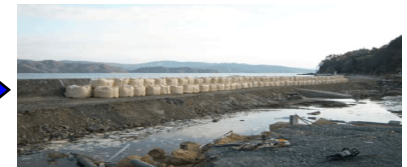
同左 応急復旧状況
