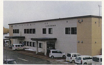
公立志津川病院（南三陸町）
