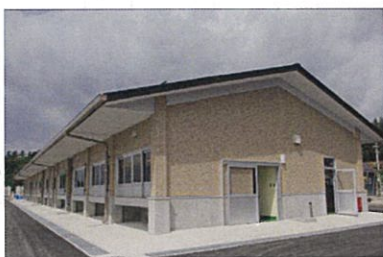
再建したカキ処理施設（東松島市）
