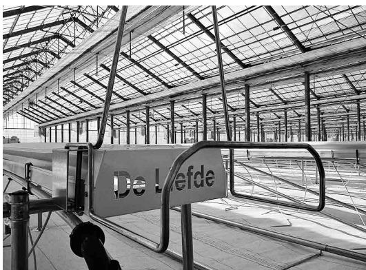
稼働間近のトマト鉄骨ハウス
