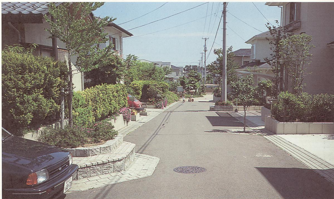
汐見台団地のボンネルフ道路。左側に植栽が見える。
