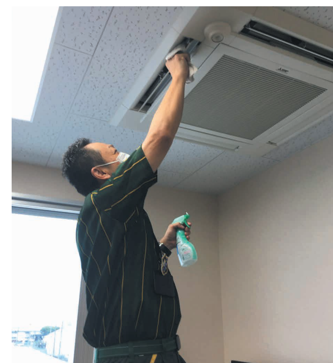
こまめな清掃で電気使用量を削減
