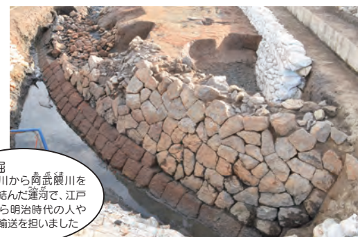
真山堀と船溜まりとの交差点のコーナー部を確認しました
