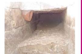
下水道施設 (暗渠) の様子
