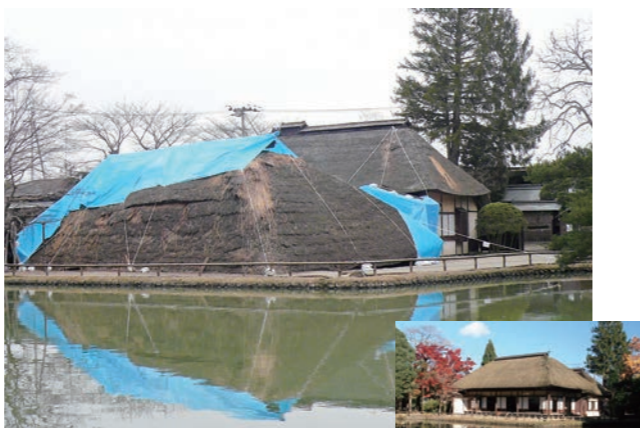
倒壊した主屋(手前)および附属屋の屋根(奥)を保護しています。
