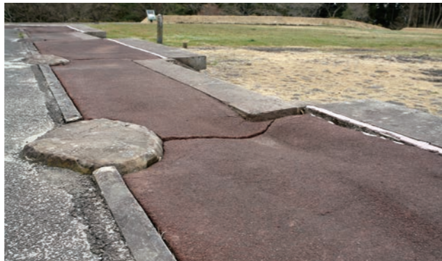
重要な政務や儀式、宴会などをおこなった政府の中心である正殿の基壇(建物の土台)の被害状況。
