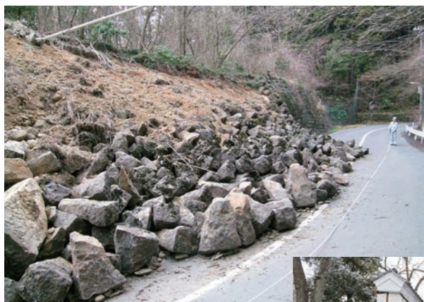
本丸北西石垣のうち約60mの範囲が崩落しました。
