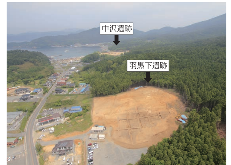
調査区全景 (上が北西)
