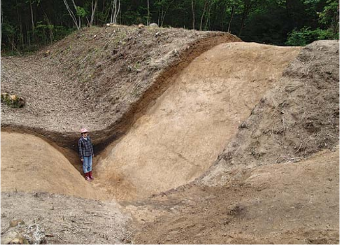
北辺の土塁跡と堀跡(h地点) 北辺や東辺の丘陵部には、土塁と堀が設けられました。北辺の土塁は幅が5.0~7.0mで、堀の底からの高さは4.5m以上ありました。
