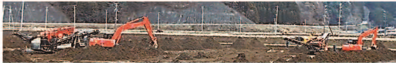
写真1 自走式石礫選別機とバックホウによる瓦礫除去作業
