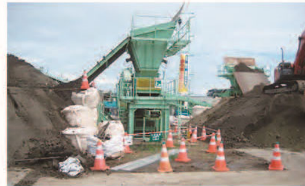
写真3 瓦礫除去プラント
