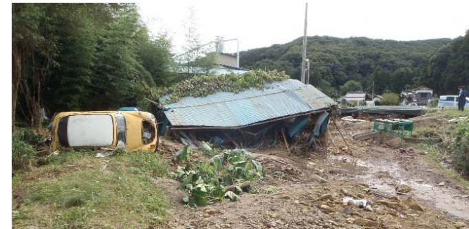
平成27年関東・東北豪雨 泉区実沢付近 農地・宅地・車両被害状況
