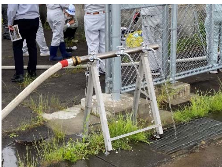
給水栓の設置
