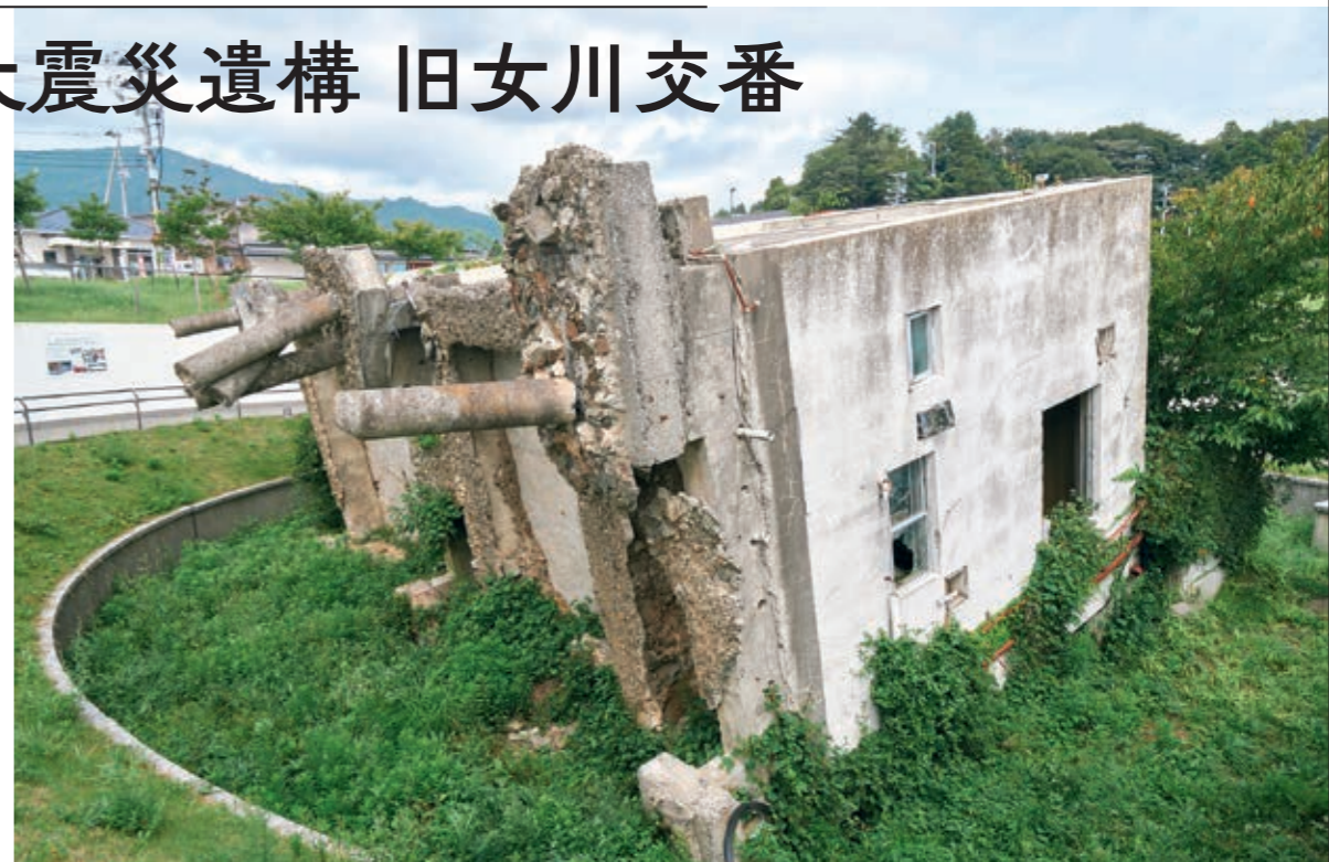
女川町の最大津波高は14.8m。引き抜かれた土の杭からも、津波の力の大きさがわかる。見守り保存のため、自然に生えてきた草木も手を加えない。
