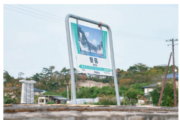
津波の威力で折れ曲がった駅名標。
