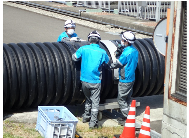
パイプバイパス水路設置作業
