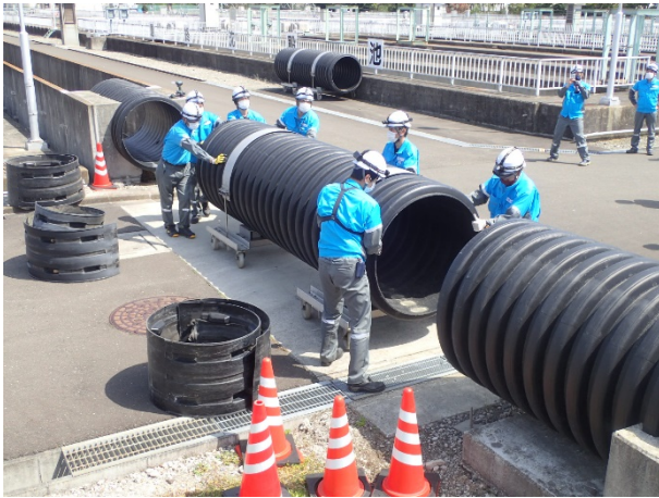
パイプバイパス水路設置作業
