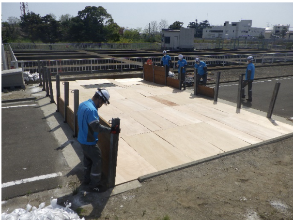
道路横断バイパス水路組立作業
