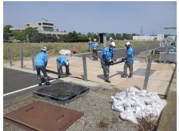
道路横断バイパス水路組立作業
